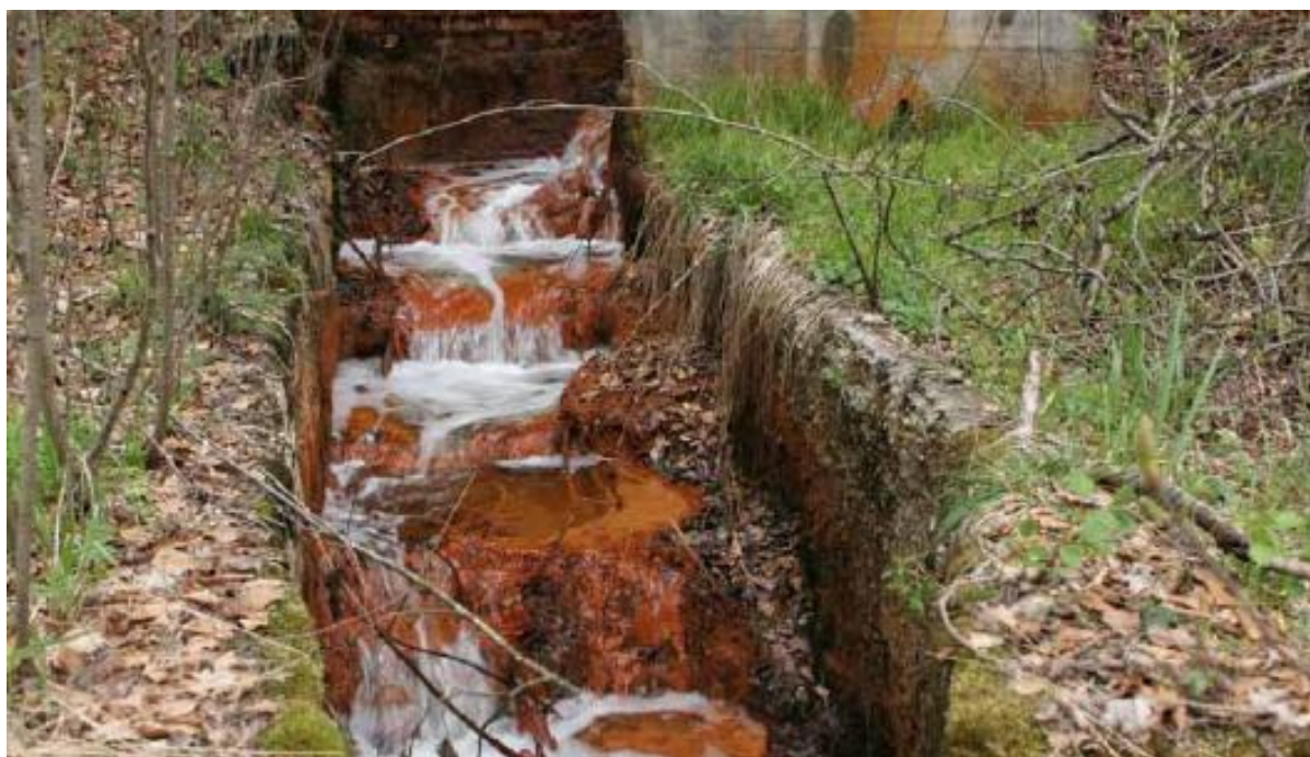
Abb. 18: Offene Belüftungstreppe nach dem Auslassventil des Friedrichstollens (Foto: Ch. Wolkersdorfer)
