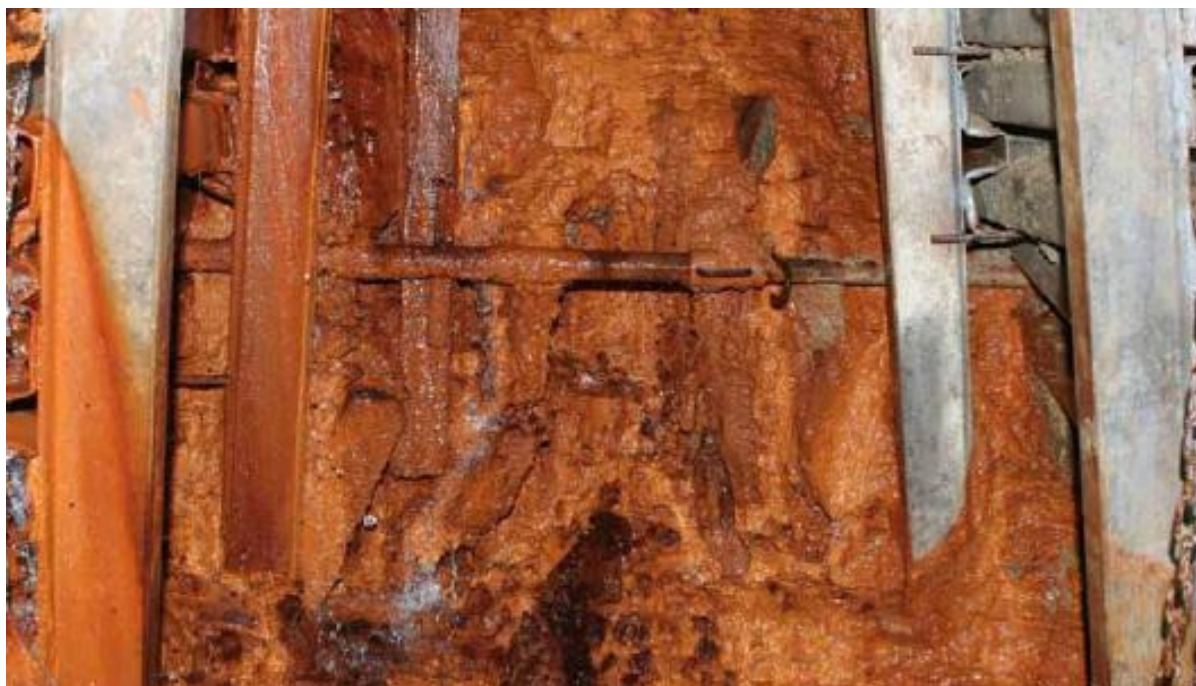
Abb. 38: Ortsbrust des Mittelstollens Peißenberg mit Ausfällungen von Eisenoxiden (Foto: Ch. Wolkersdorfer)
